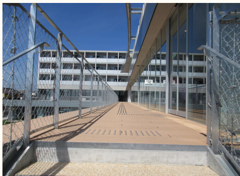
階段を上がって直進します
