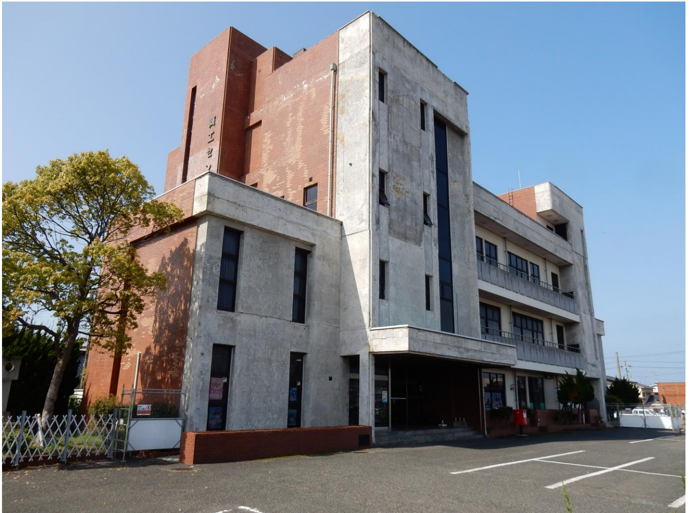
■ 解体される商工センター
